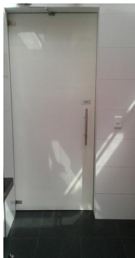
Figura 2. Puerta de acceso baño
